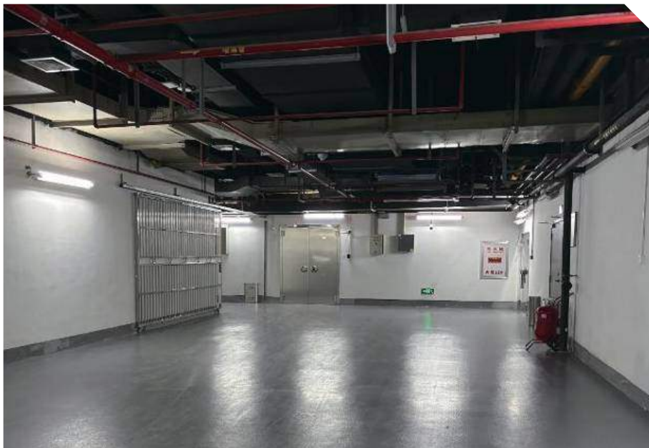
■ 北馆库房铺设好的地板胶
