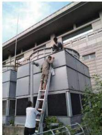
■ 图9 冷却塔检修
