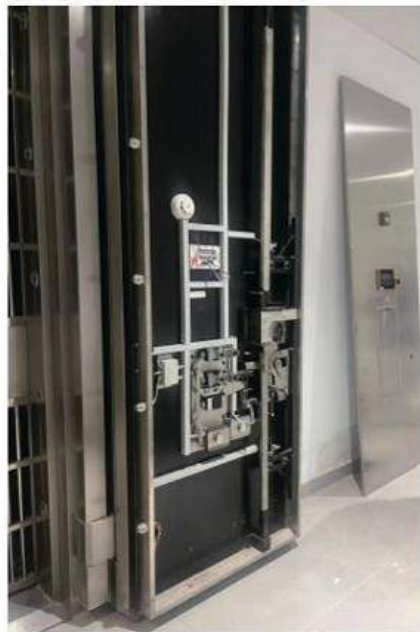
■ 南馆新库房、库房门维保
