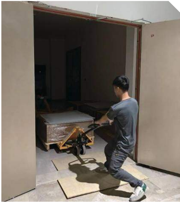
■ 南馆库房地板胶铺设施工
