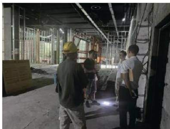
■ 展陈工作人员反复去施工现场确认进度及完成质量情况
