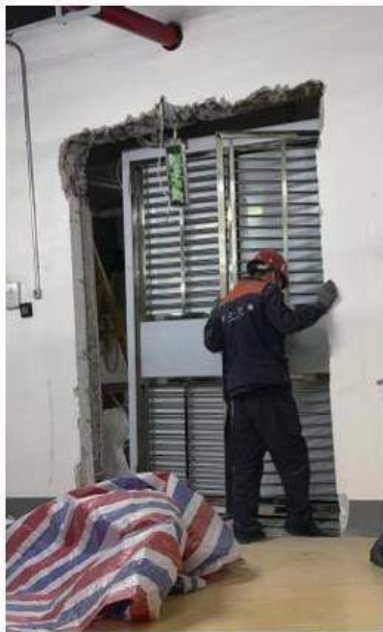
■ 北馆库房换新门
